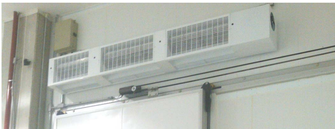
Exemplo de cortina de ar instalada com motor do lado direito, devido a coluna do lado esquerdo
